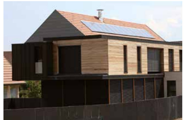
Des panneaux photovoltaïques bien implantés: sur la pente d'un toit, en exposition sud, sans ombre gênant l'ensoleillement.
