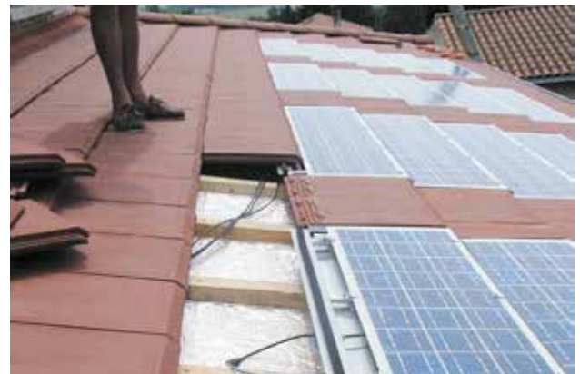
Intégration en toiture de tuiles photovoltaïques.
